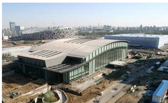
Die Baustelle der Olympiahalle in Beijing.
