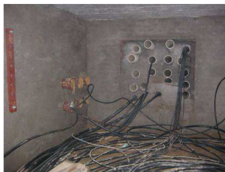
Abdichtung der Luftkanäle mit KÖSTER Produkten.
